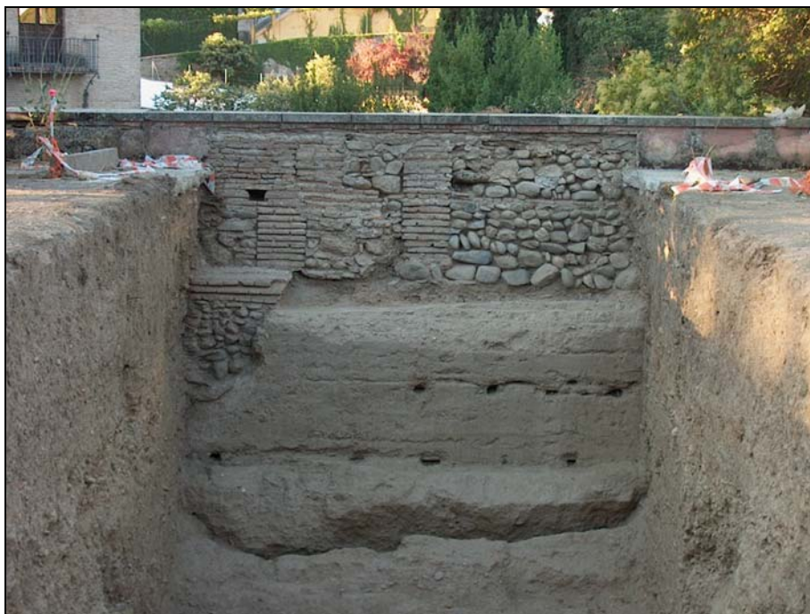
Fotografía 4. Detalle del muro islámico y su unión con la reconstrucción del s. XX
