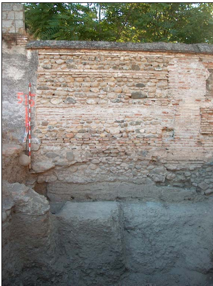
Fotografía 6. Detalle de la tapia de cierre del Carmen del Negro, sobre los restos de tapia islámica
